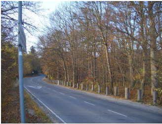
Exelbergstrasse zwischen Profil C-C und E-E (Blickrichtung stadtauswärts)
